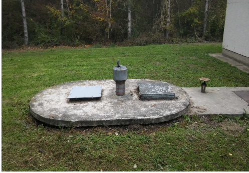
Außenansicht Vorschacht Bohrbrunnen
