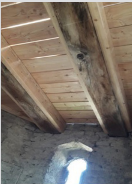
Neue Zwischendecke (Kirche)
